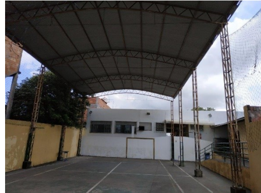
Foto nº 7 – Vista interna da quadra coberta
