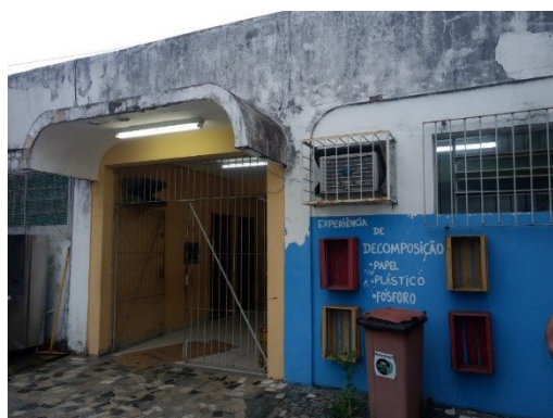
Foto nº 2 – Vista da fachada do Bloco 2
