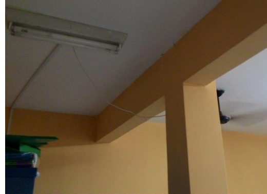
Foto nº 25 – Detalhe das vigas e pilares em concreto armado da coordenação localizada no Bloco 2
