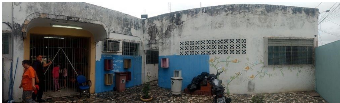
Foto nº 1 – Vista das fachadas do Bloco 2 a esquerda e Bloco 1 a direita
