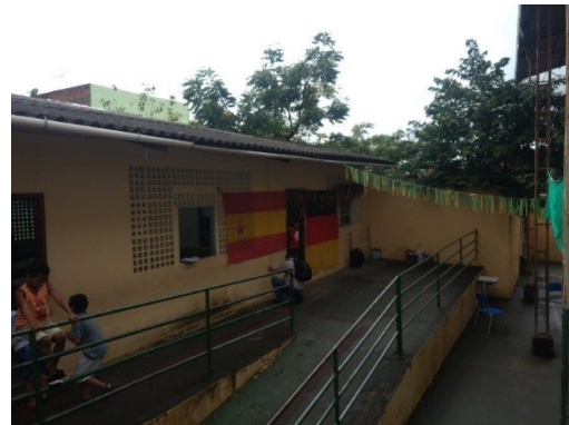
Foto nº 27 – Vista das rampas existentes entre o Bloco 3 a esquerda e Quadra a direita
