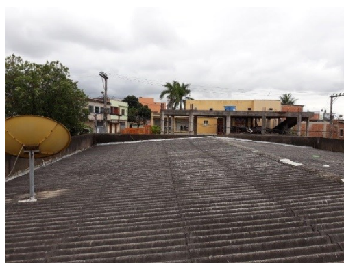
Foto nº 3 – Vista da cobertura do Bloco 2
