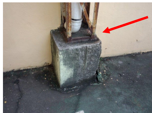
Foto nº 11 – Detalhe do pilar metálico da quadra coberta apresentando perda de espessuras
