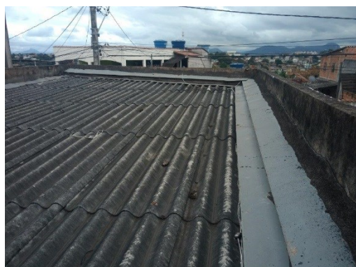
Foto nº 4 – Vista da cobertura do Bloco 1
