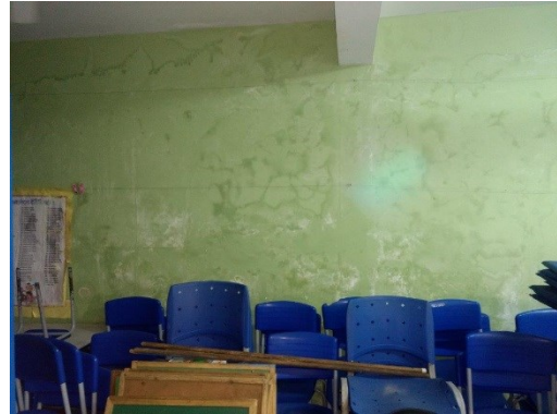
Foto nº 13 – Sinais de infiltração na parede da sala de aula do Bloco 2
