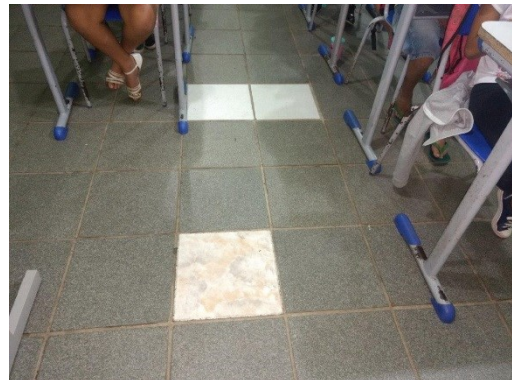
Foto nº 15 – Reparos com outros tipos de piso nas salas de aula do Bloco 2
