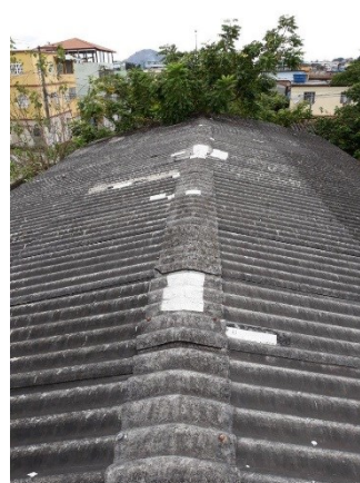
Foto nº 5 – Vista da cobertura do Bloco 3
