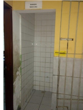
Foto nº 19 – Porta de entrada do sanitário masculino dos alunos localizado no Bloco 2
