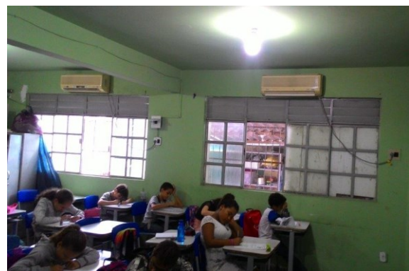
Foto nº 17 - Vista interna de sala de aula Bloco 3 com destaque para os condicionadores de ar
